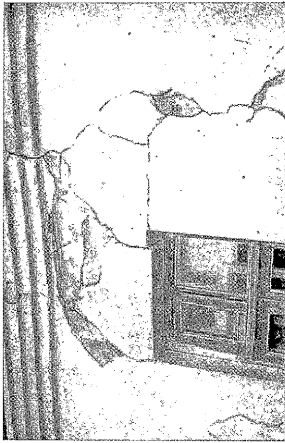
Фиг. 2. Детский сад. Трещины до 1—2 см, в стенах выбиты перелеты рам
